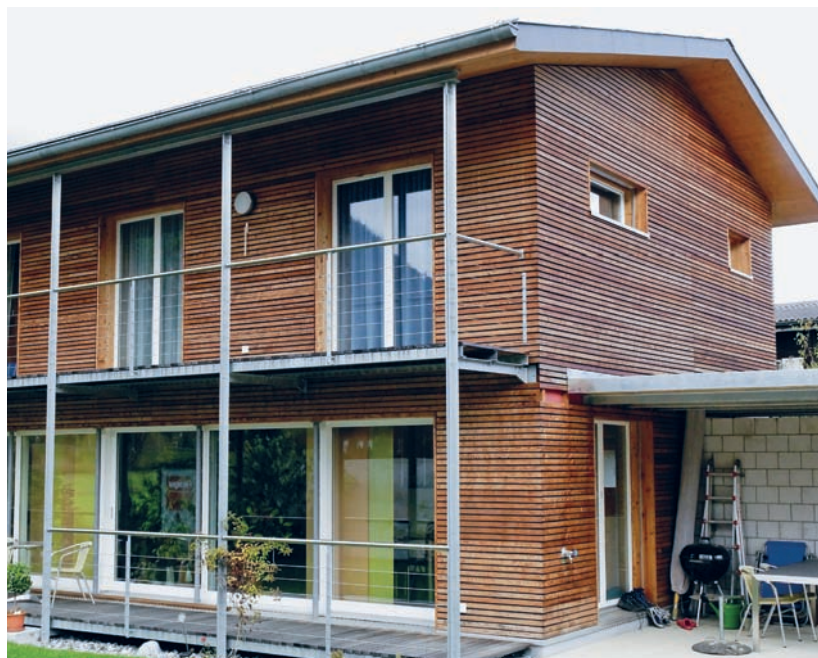
Ansicht Süd mit Lärchenleistenschalung 35/45 mm
