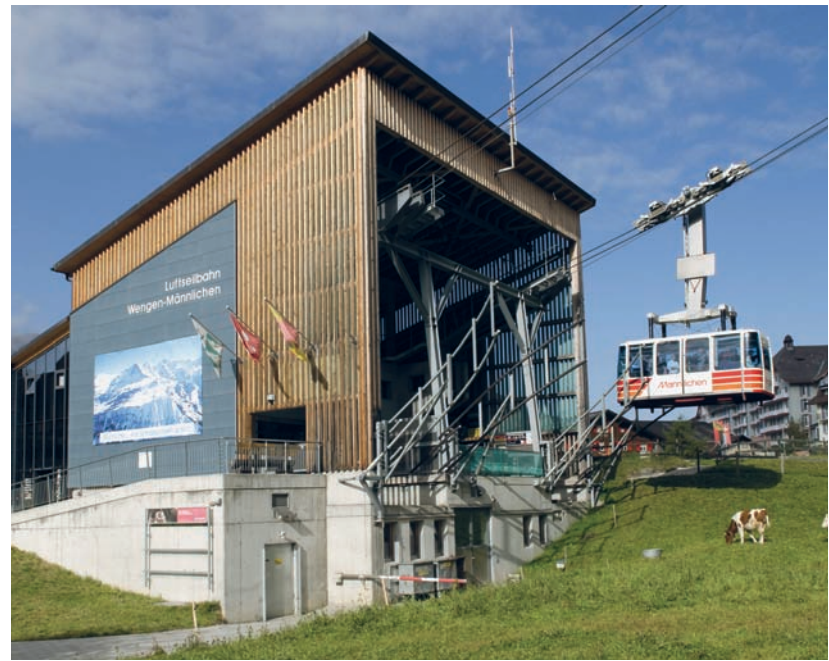
Gebäudehülle in Holz - filigran und transparent
